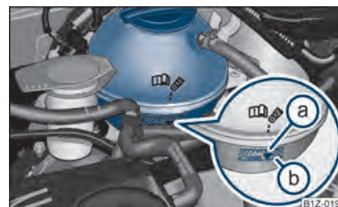
Obr. 152 Motorový prostor: nádržka chladicí kapaliny
